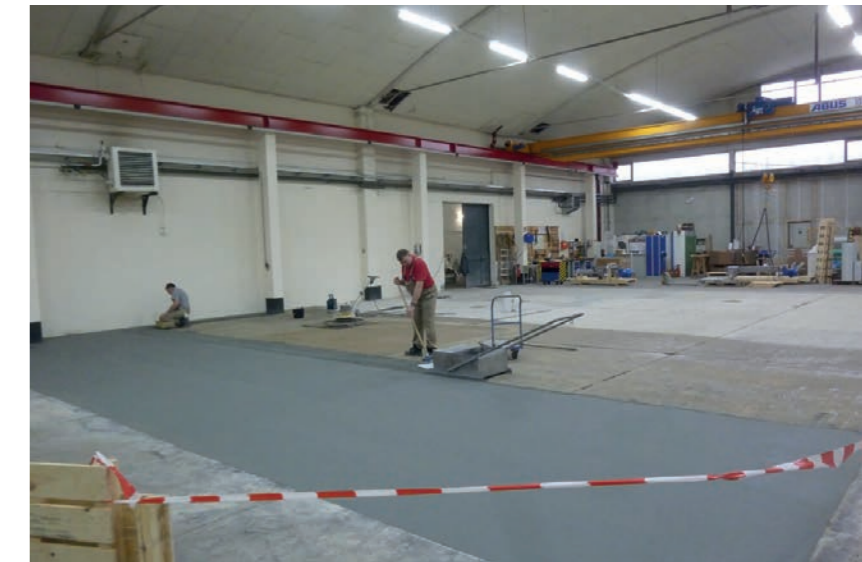
Rénovation du plancher dans le hall d'expédition
