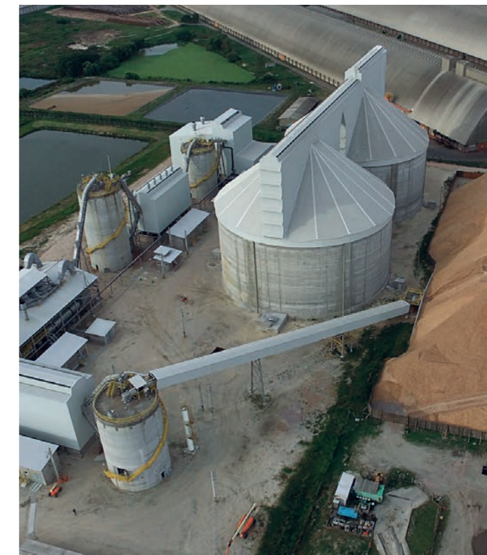
Installation de granulation de bois en Brésil
