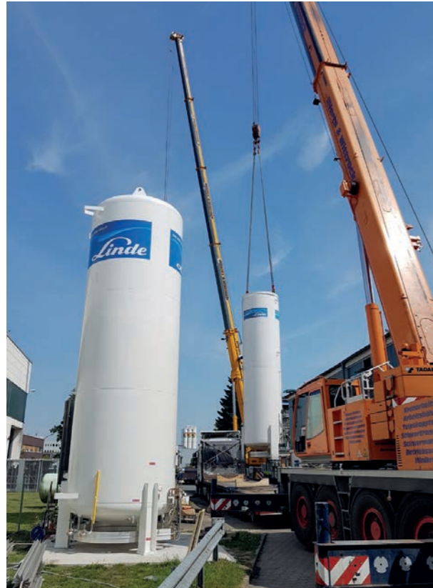
Remplacement de l'installation d'azote
