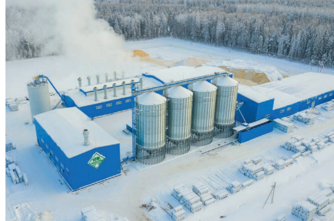
Installations de granulation de bois en Russie
